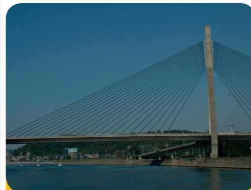
Afb. 3 - Hangbrug over de Maas
