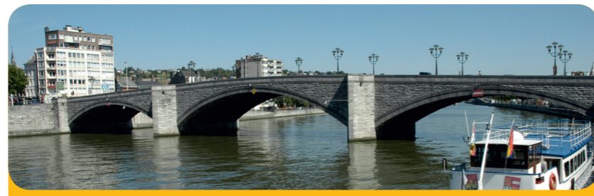
Afb. 2 - Boogbrug over de Maas
