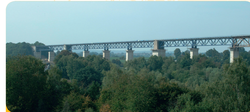
Afb. 4 - Bijna 100 jaar oud en met ruim 1100 meter één van de langste spoorbruggen van Europa: viaduct van Moresnet.
